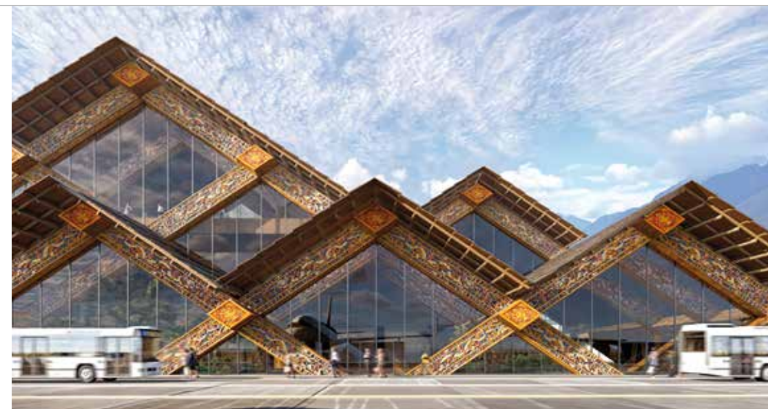
Die diagonale Struktur des Flughafens wird aus lokalem Holz gefertigt und ist mit traditionellen bhutanischen Holzschnitzereien verziert.
