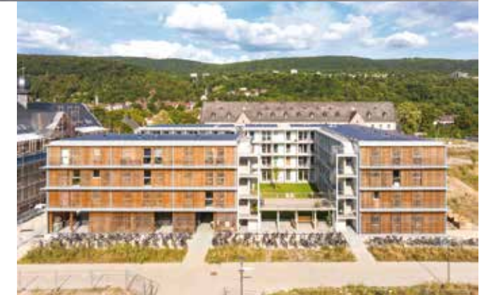
Ein rückbaubares Studierendenwohnheim in Holzbauweise
