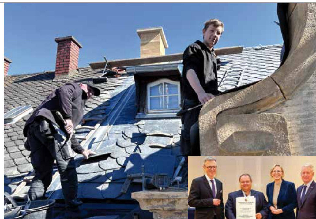
Mitarbeiter sanieren ein altes Schieferdach.
