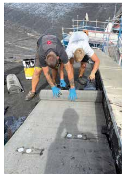
Der Neigungswinkel bildete eine Heraus- forderung bei der Dachsanierung der Alsterschwimmhalle in Hamburg.
