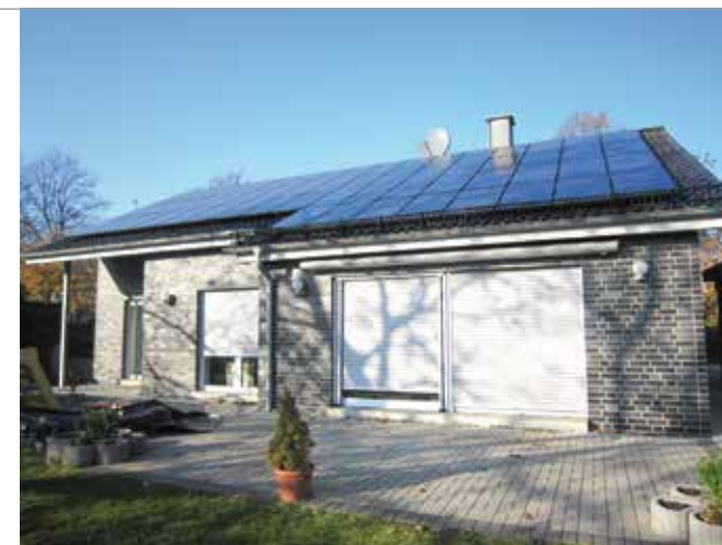
Klassisches PV-Geschäft: ein privates Einfamilienhaus.
