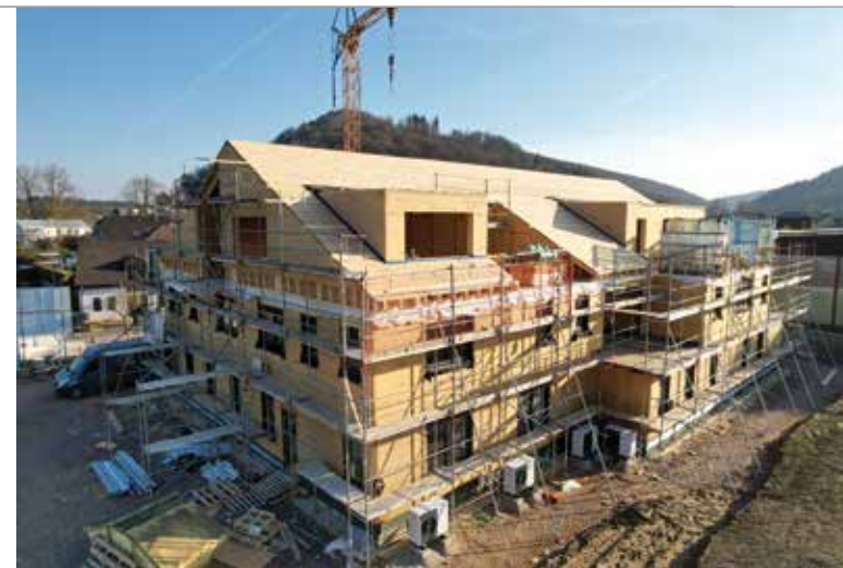
Ein Holzbauprojekt made by Holzbau Dawen.
