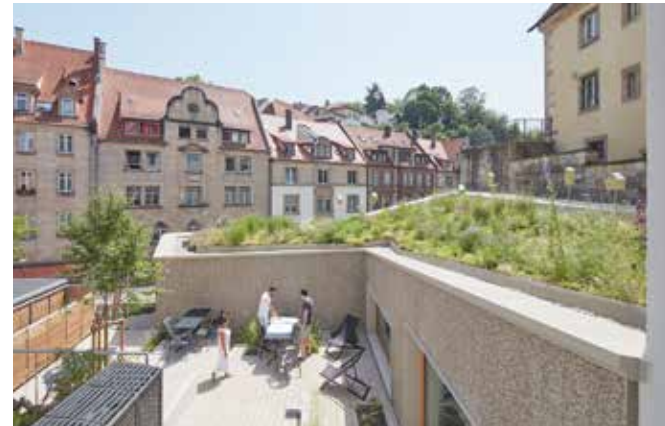
Die dreifach terrassierte Dachlandschaft ist auch von den angrenzenden Wohnungen aus einsehbar.
