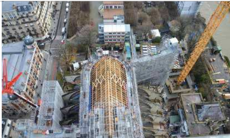
Blick auf den Dachstuhl von Chor und Apsis, vom Gerüst rund um den Turm aus.
