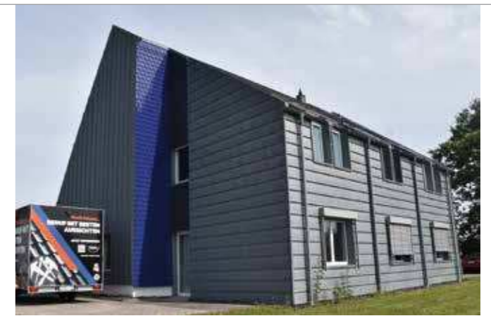
Der Landesverband Hessendach hat alle Gebäude ohne Fördermittel finanziert, eine weitere Ausbildungshalle ist in Planung.
