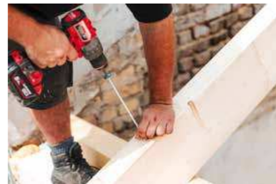
Die Holzbalken werden verschraubt.
