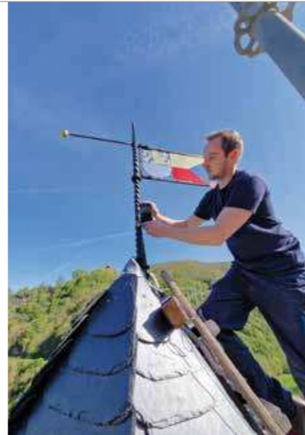
Dachsanierungen mit Schwerpunkt Schiefer sind die Spezialität des Betriebs.
