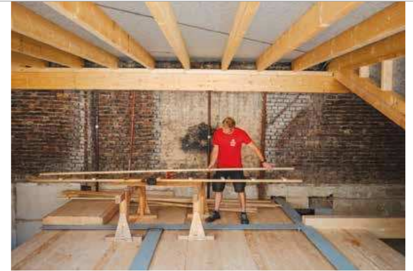
Die Innenansicht mit den massiven Holzbalken für ein schönes Wohnambiente.
