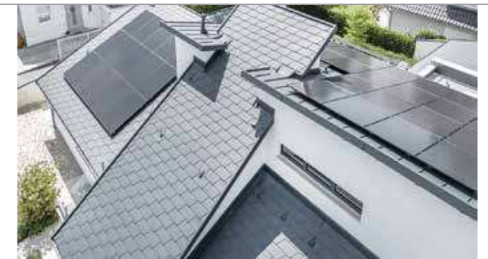
Die Verschneidungen der Dachflächen boten eine echte Herausforderung für das Sindermann-Team.
