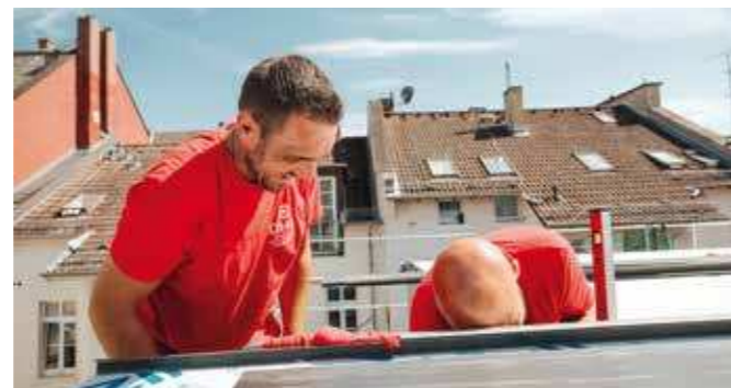
Abschließende Arbeiten oben am neuen Flachdach.
