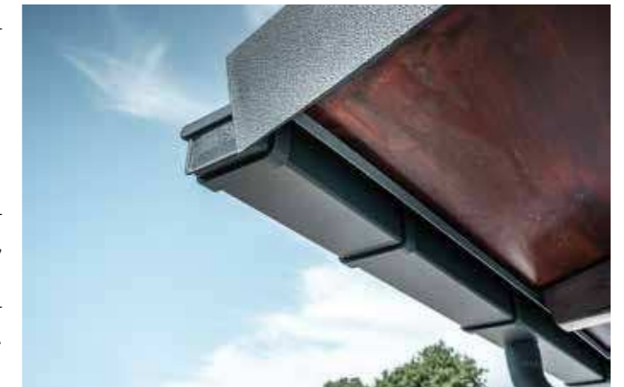
Schönes Detail: die vorgehängte, kastenförmige Dachrinne aus Aluminium.
