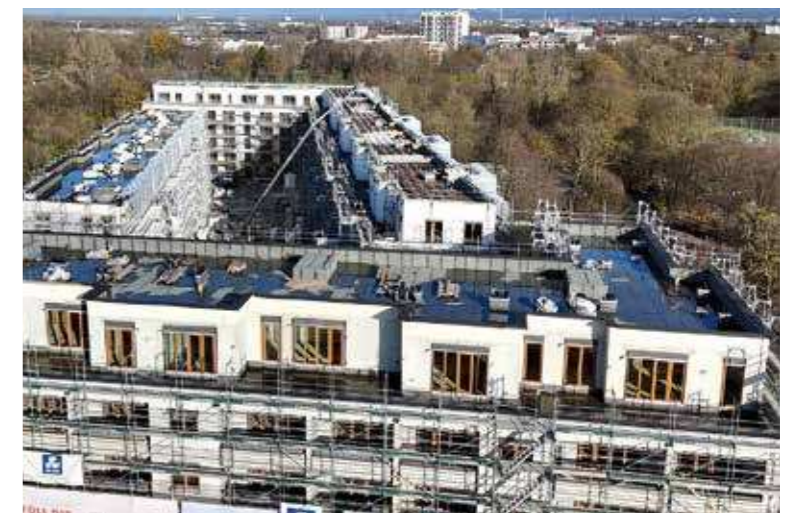
Aktuelle Großbaustelle in der Kölner Innenstadt mit Abdichtungen und Dämmung, Abdeckungen aus Aluminium, Terrassenplatten, PV-Anlagen und Dachbegrünung.
