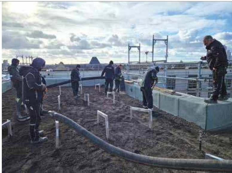
Die Mitarbeiter bringen Granulat auf für die Dachbegrünung.
