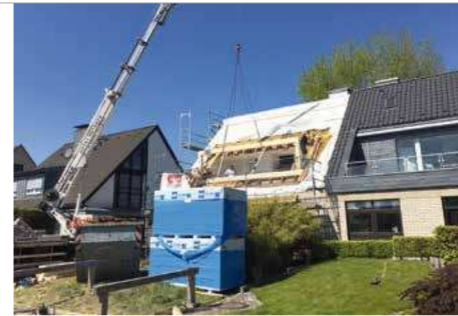
Dachgeschossausbau für einen Privatkunden.
