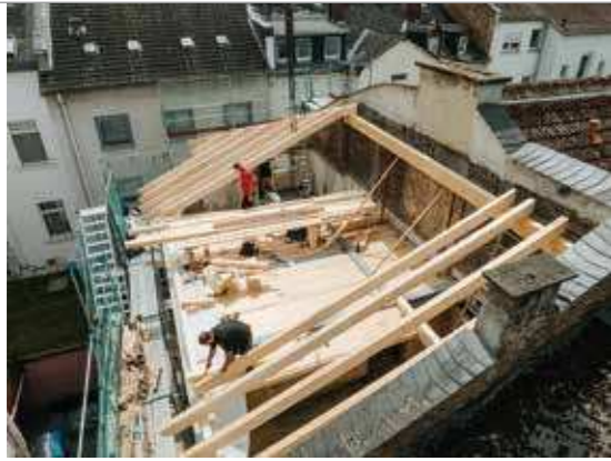
Die Drohne gibt einen guten Überblick zur Dachaufstockung mitten im Wohngebiet.
