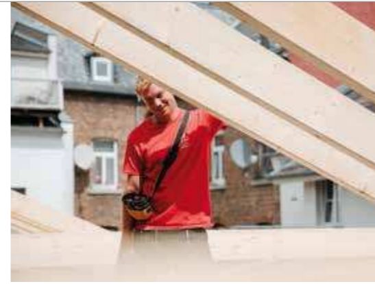
Den Dachstuhl hat das Team auf der Baustelle innerhalb von zwei Tagen zusammengezimmert.
