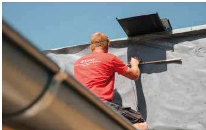
Aufmaß für die Stehfalz-Verkleidung
