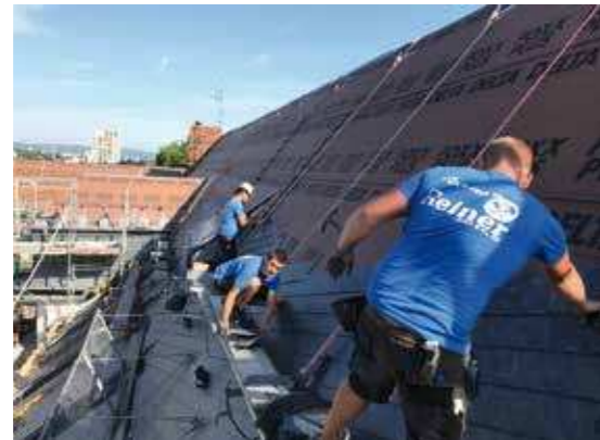
Die Kontrolle der Kosten auf laufenden Baustellen ist enorm wichtig, damit am Ende mit einem Projekt auch wirklich Geld verdient werden kann.
